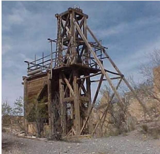
Entrada al tiro principal de la mina Nuevo Mercurio
