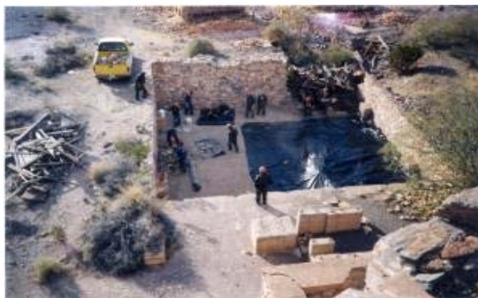
Colocación del plástico en fosa de carga de la mina
