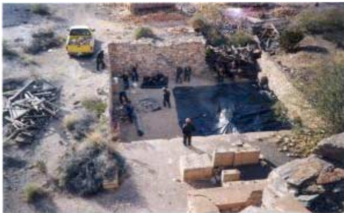
Colocación del plástico en fosa de carga de la mina
