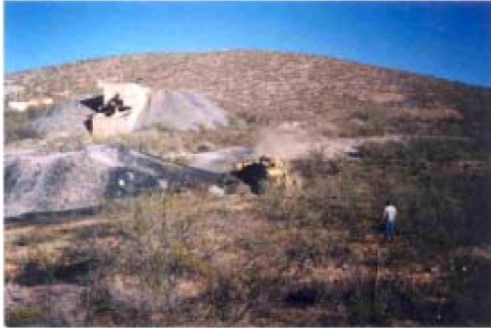
Trabajo de construcción de fosa y recolección de BPC, terrero zona este
