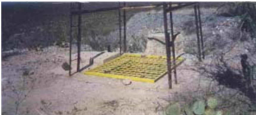
Cubrimiento con rejilla metálica de uno de los tiros de la mina
