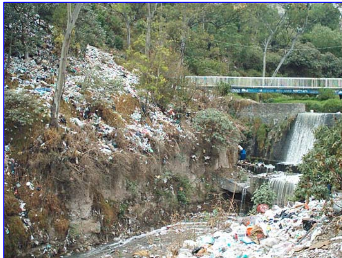
Fig. 9 Presa en un tributario de la Barranca Becerra es foco de infección y corre peligro de sobresaturarse e inundar las colonias ubicadas río abajo
